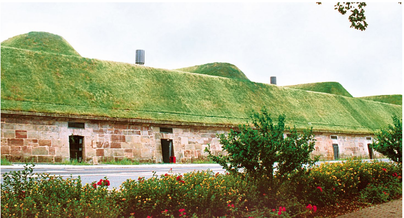
Kasematten am Kasemattenhof, Saarlouis
